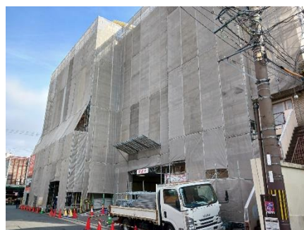
京都祇園改修現場
