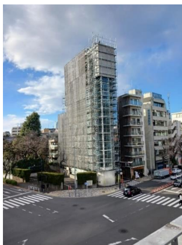
東京外苑前大規模改修現場
