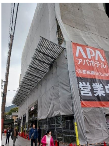
四条通沿改修現場
