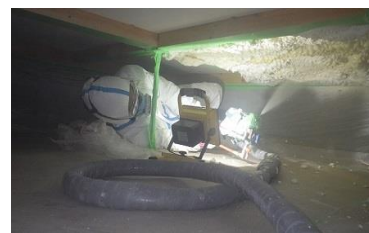
床下断熱工事
