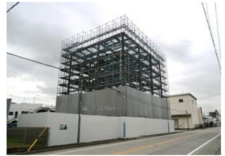
新本社建設工事の進捗
