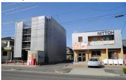
三河営業所建設中
