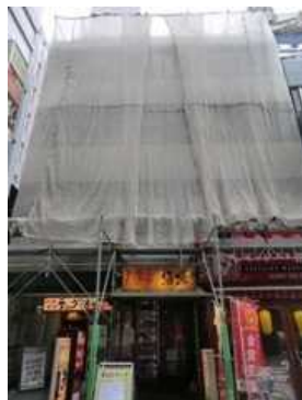
上野御徒町外壁改修
