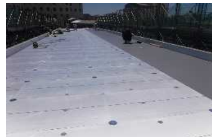
平場シート敷設状況
