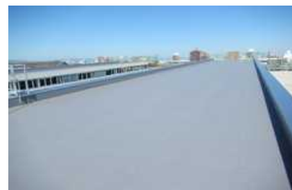
JR東海関連Ⅰ期工事施工完了
