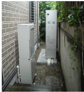
エネファーム設置後
