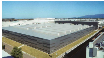
YKK工場完成全景
