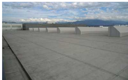
YKK工場屋上の様子
