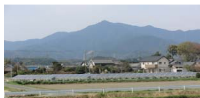
74.88KWシステム
